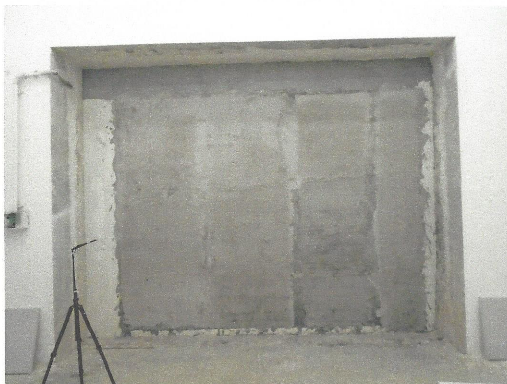
FOTO 2 – Detaliu de montaj al Peretelui de zidărie realizat din blocuri ceramice EC 44 VB , în standul de izolare la zgomot aerian (vedere din camera de emisie)
