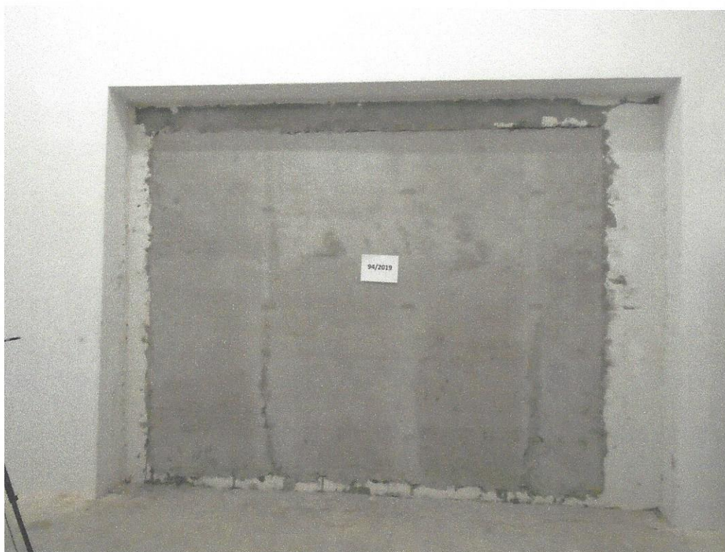
FOTO 1 – Detaliu de montaj al Peretelui de zidărie realizat din blocuri ceramice EC 44 VB , în standul de izolare la zgomot aerian (vedere din camera de recepție)
